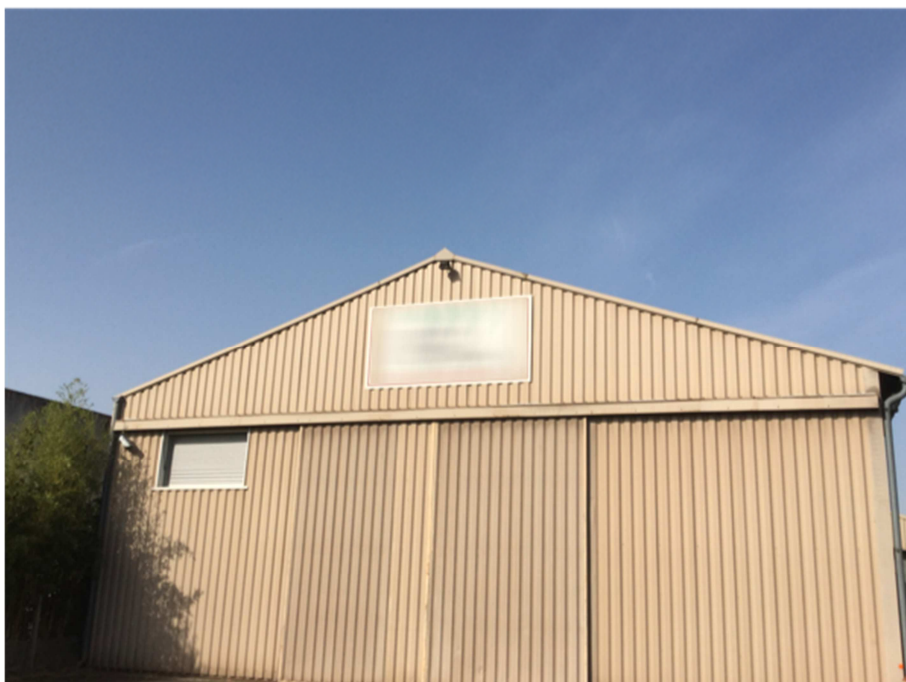
Enseignes dépassant les limites de l'égout du toit - Rue Jean Rostand, Combs-la-Ville, août 2018
