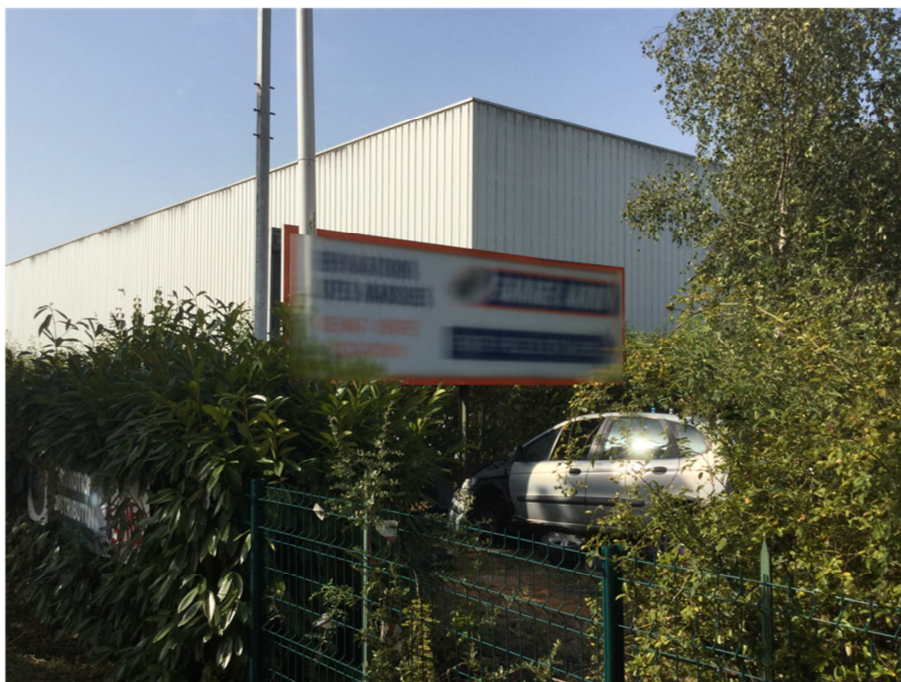
Dispositifs publicitaires scellés au sol implantés à moins de la moitié de leur hauteur d'une limite séparative de propriété– avenue André Malraux, Combs-la-Ville, 08/2018
